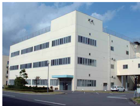
日立電線グループデータセンター Hitachi Cable Group's data center
